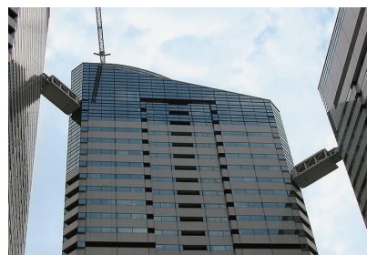
ビル同士をつないで振動を抑える連結制振
